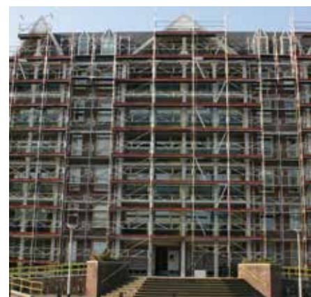
▶ Blitz-steiger met ladderopgang.
