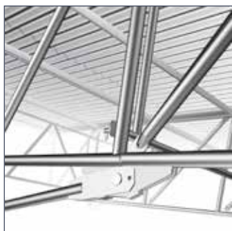
Trekstang-aansluiting
